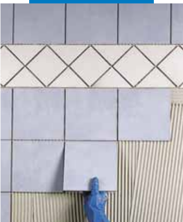
Colocación de monococión en pared de baño sobre revoco
