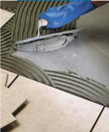
Colocación de monococión en pavimento
