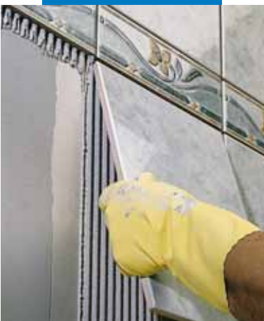
Colocación de monococión en pared sobre yeso laminado (cartón-yeso)
