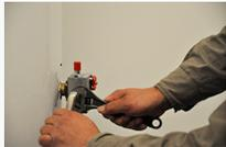
Enrosque la tuerca y virola de 3/8" en la entre rosca que colocó en la entrada de gas del termotanque.
