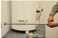
Extienda el flexible hasta alcanzar la longitud necesaria para conectarlo con la entre rosca colocada en el termotanque (longitud del flexibles: de 40 a 105 cm)
