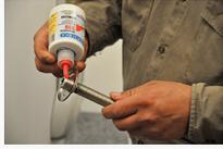
Tome la Conexión APROBADA Flexible Extensible para Termotanques, modelo CAFETE, y coloque el sellador aprobado para gas en los tres primeros filetes del terminal macho fijo 1/2". Para una mejor terminación, utilice una Roseta modelo RDT.
